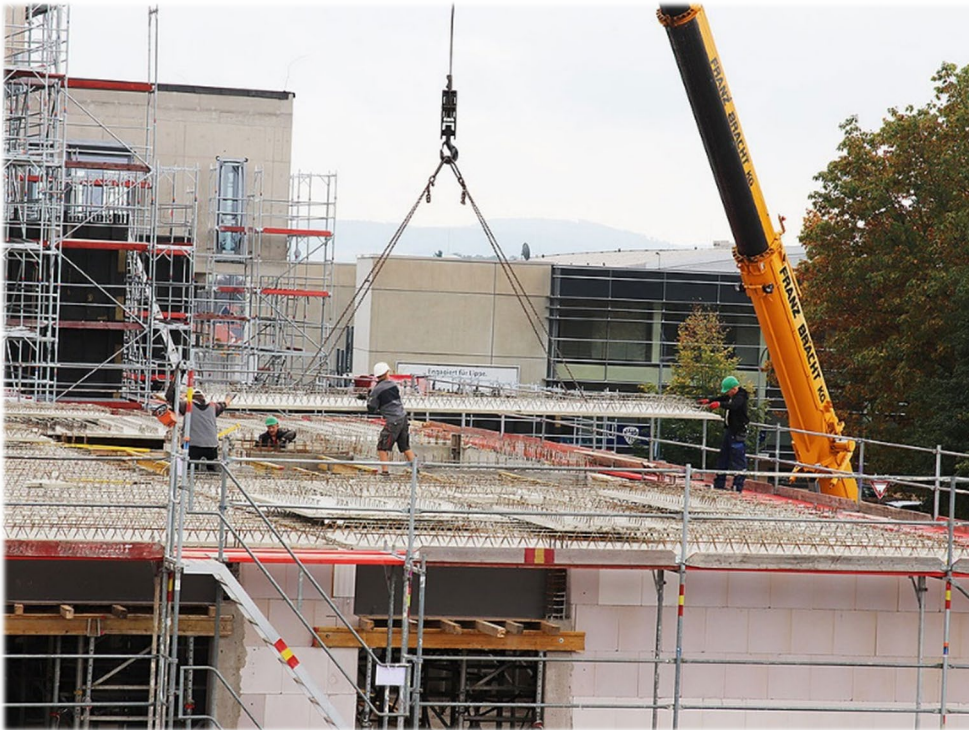
15.10.2021: Das Dach wird montiert
