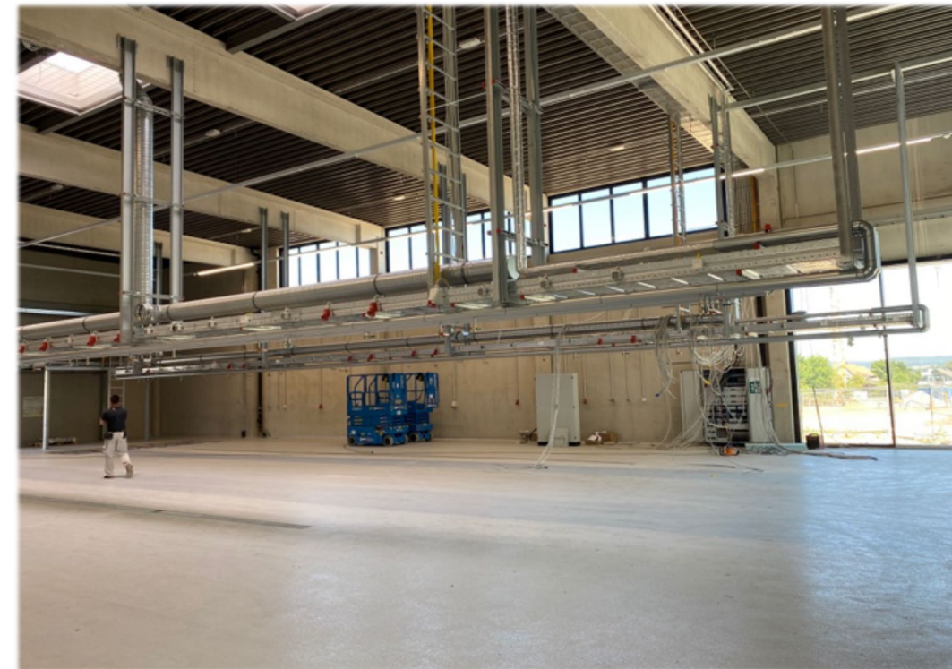
Q2 2022: Feinarbeiten im Innenausbau – Montage der Medientrasse
